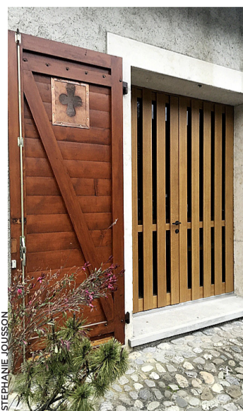
Une des portes du local.
